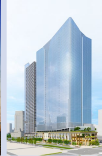
日本橋一丁目東地区再開発事業 中央区 商業/業務/カンファレンス等 延床面積：274千㎡（A街区） 2032年3月期竣工予定
