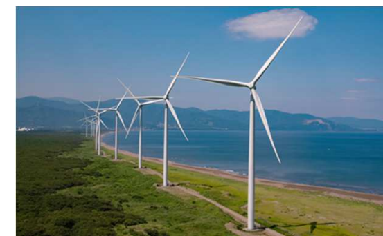
ReENE Zenibako wind power plant(Hokkaido) : 34MW
