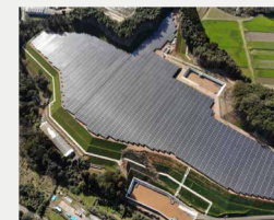
リエネ出水太陽光発電所
