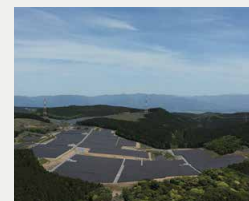
リエネえびの太陽光発電所
