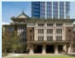
「九段会館テラス」 (東京都千代田区)
