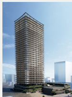
プランズタワー西宮 所在地：兵庫県西宮市 総戸数：377戸
