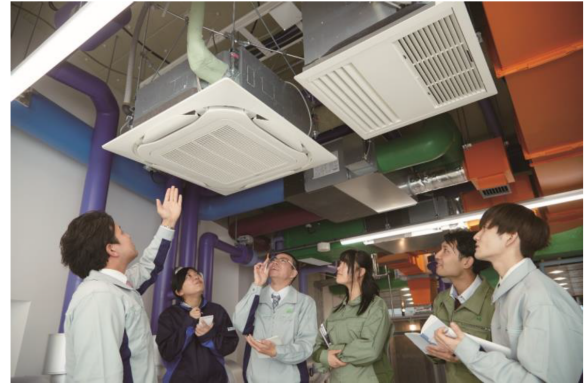
設備実習フロア
