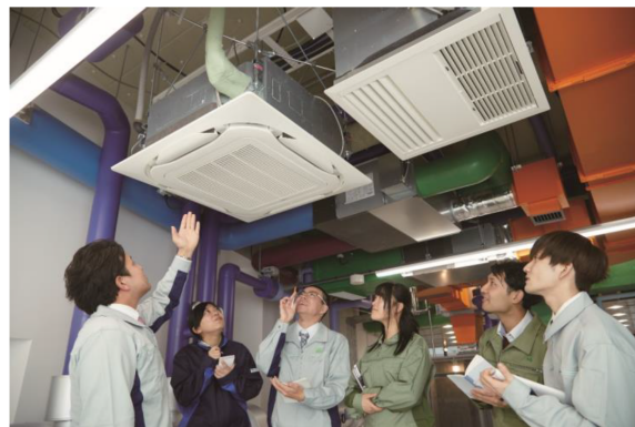
設備実習フロア
