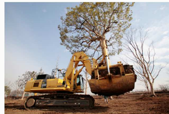
TPM機械による移植作業
