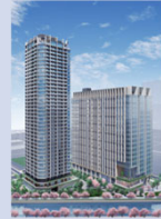
大崎リパークワークガーデン 品川区 オフィス/商業/住宅等 延床面積：69千㎡（事務所棟） 2027年3月期竣工予定
