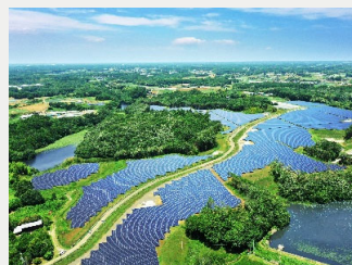
リエネ行方太陽光発電所（茨城県） 定格容量：28MW （2021年3月期運転開始）
