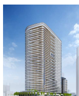
白金一丁目西部中地区 再開発事業 所在地：東京都港区 総戸数：約950戸
