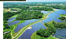
リエネ行方太陽光発電所 (茨城県) 定格容量：28MW (2021年3月期運転開始)
