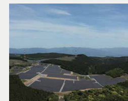
リエネえびの太陽光発電所
