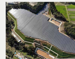
リエネ出水太陽光発電所
