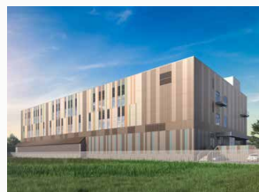
再エネ100%データセンター (北海道石狩市)
