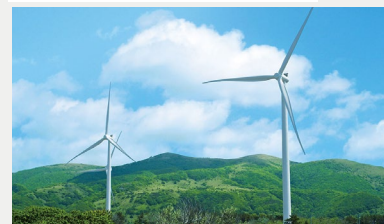
リエネ松前風力発電所
