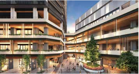
THE TOWER JUJO (ザ・タワー十条)
