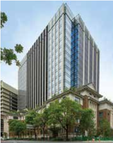
九段会館テラス 東京都千代田区
