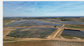
バルデカレラス太陽光発電所 (スペイン) 定格容量: 38MW (2023年12月商業運転開始)
