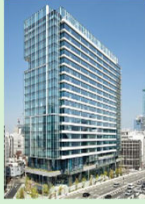
渋谷ソラスタ 渋谷区 オフィス 延床面積：47千㎡ 2019年3月竣工
