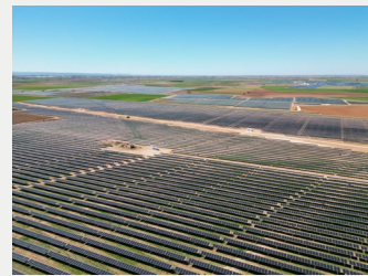
マンサナレス太陽光発電所 (スペイン) 定格容量：40MW (2023年6月商業運転開始)
