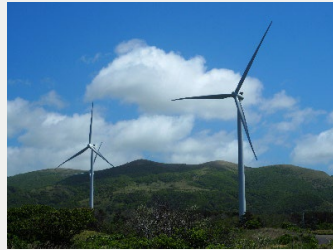
リエネ松前風力発電所 (北海道) 定格容量：41MW (2020年3月期運転開始)
