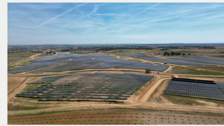
バルデカレラス太陽光発電所 (スペイン) 定格容量：38MW (2023年12月商業運転開始)
