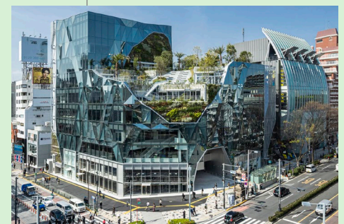
東急プラザ原宿「ハラカド」 渋谷区 商業/公共公益施設 延床面積：20千㎡ 2024年4月開業
