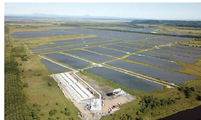
すずらん黒路町太陽光発電所：92MW (2020年2月運転開始)
