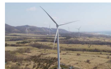
リエネ松前風力発電所
