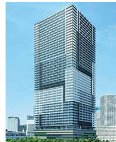
プラッス ター豊洲 (2021年10月竣工予定)
