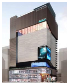
キュープラザ池袋 豊島区 商業/映画館 延床面積：17千㎡
