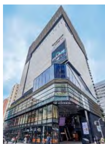
キュープラザ池袋 豊島区 商業/映画館 延床面積：17千㎡
