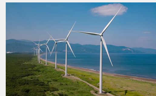
リエネ銭函風力発電所(北海道)：34MW
