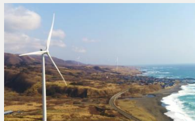
リエネ松前風力発電所
