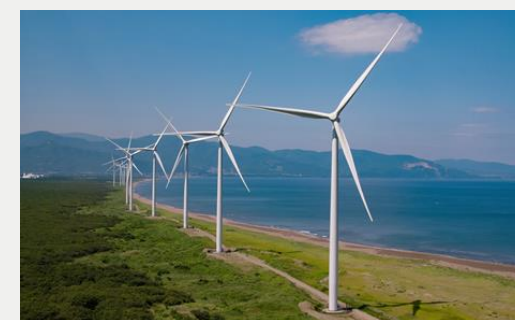
リエネ銭函風力発電所(北海道)：34MW
