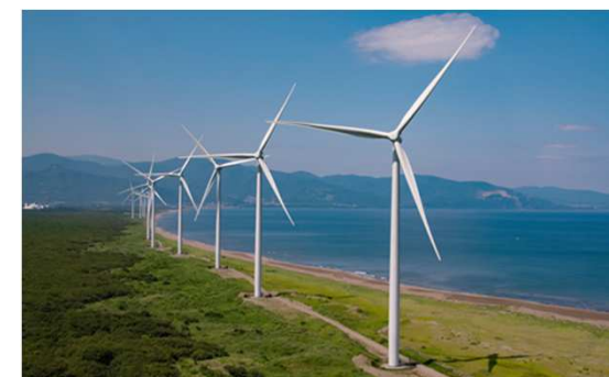
リエネ銭函風力発電所(北海道)：34MW
