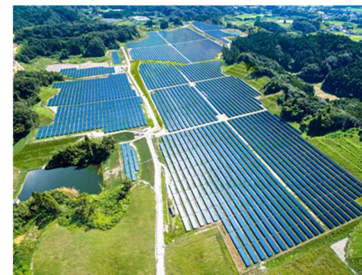
リエネ長南太陽光発電所(千葉県)：24MW (2020年7月運転開始)
