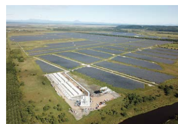
すずらん釧路町太陽光発電所
