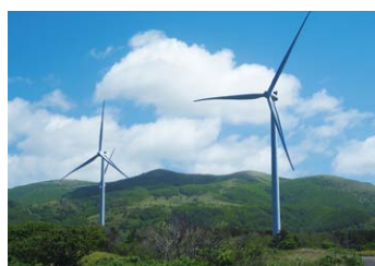
リエネ松前風力発電所
