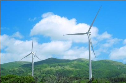
リエネ松前風力発電所
