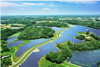
リエネ行方太陽光発電所
