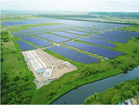
すずらん黒路町太陽光発電所
