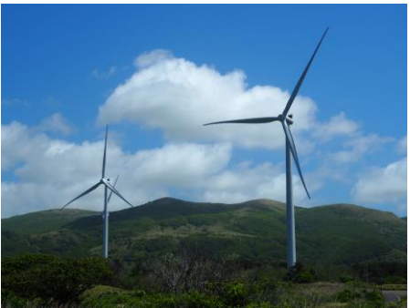
リエネ松前風力発電所
