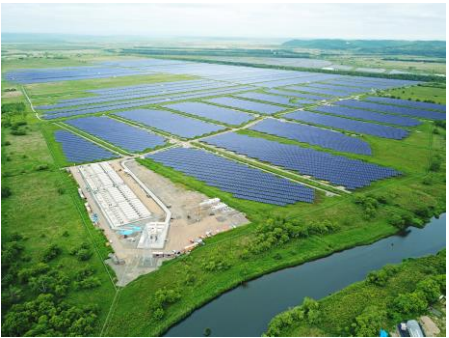
すずらん釧路町太陽光発電所
