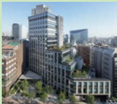
新目黒東急ビル 屋上庭園
