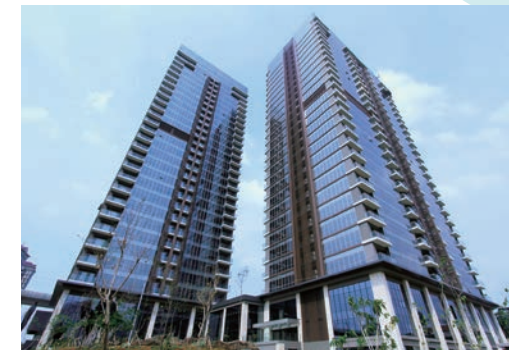
BRANZ SIMATUPANG (2018年12月竣工)
