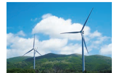
リエネ松前風力発電所 (2019年4月運転開始)
