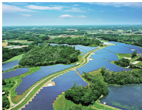
リエネ行方太陽光発電所
