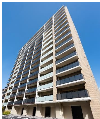
マンション／地方
