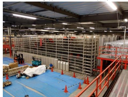
自律搬送型ロボット用棚組立
