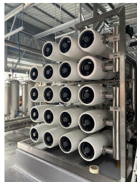
写真: キリンの豪州子会社が醸造所に導入した水の再生設備
