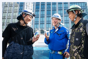
① 建設現場でサンプリング
