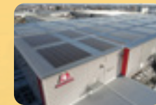
高崎森永(株)において太陽光発電電力の受電を開始
