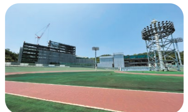
玉野競輪場工事現場
