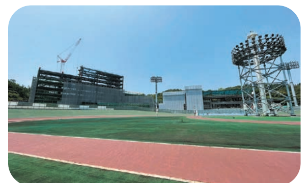
玉野競輪場工事現場
