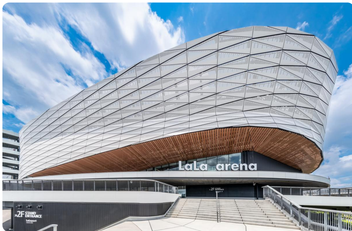
「LaLa arena TOKYO-BAY」 外観
