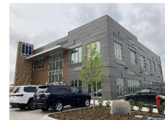
ITC（サギノー工場内に併設）
