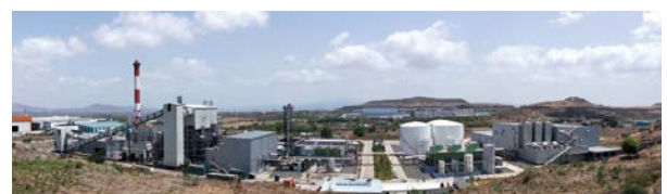
8月に稼働したイースト工場。排水を工場敷地内で再利用して敷地外に排水しないゼロ排水（ZLD: Zero Liquid Discharge）システムを導入している（OY インド）
