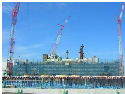
(製粉福岡新工場の工事風景:2012年10月)
