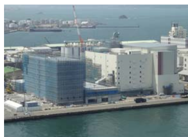
(建設中の福岡新工場 2013.4撮影)
