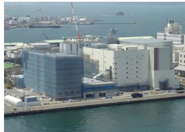
(建設中の福岡新工場 2013.4撮影)
