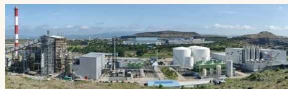
建設中のインドイースト工場
