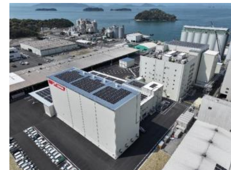
日清製粉(株) 水島工場（'25年5月稼働）
