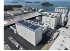
日清製粉(株) 水島工場 ('25年5月稼働)
