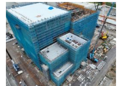
建設中の水島工場 には新技術を導入
