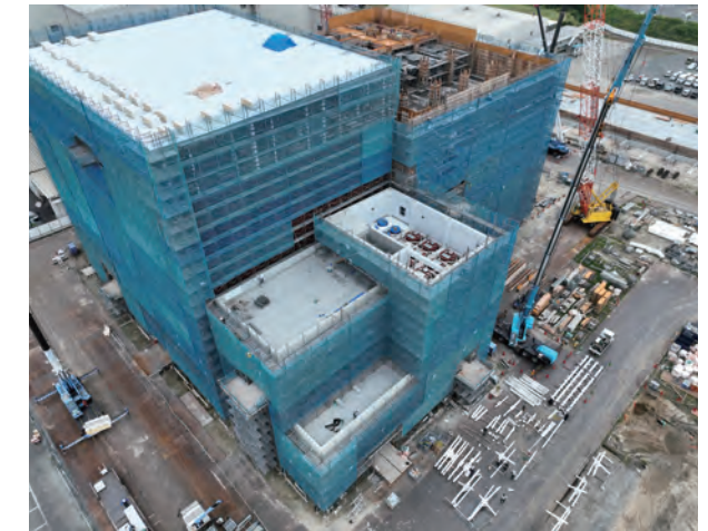
日清製粉水島工場(2025年5月頃の稼働に向けて建設中)
