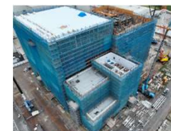
建設中の水島工場には新技術を導入
