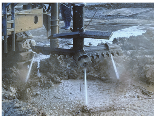
写真1 専用攪拌翼による噴射状況
